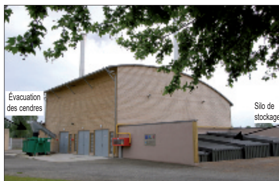
Exemple de l'hôpital de Pontorson (P b ois = 2,2 MW pour une capacité d'accueil de 460 lits).
